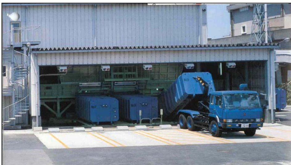
شکل (۲-۵۳) تریلرهای حمل مورد استفاده در ایستگاه مجهز به فشرده ساز
